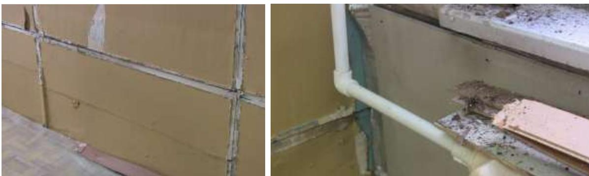
В июне - июле месяце в помещении велись ремонтные работы. Потолок был оклеен потолочной плиткой. Работники хозяйственной группы МБОУ ДО ЦДОД «Созвездие» утеплили стены плитами из минеральной ваты, с помощью реек произвели выравнивание стен для установки настенных панелей.
